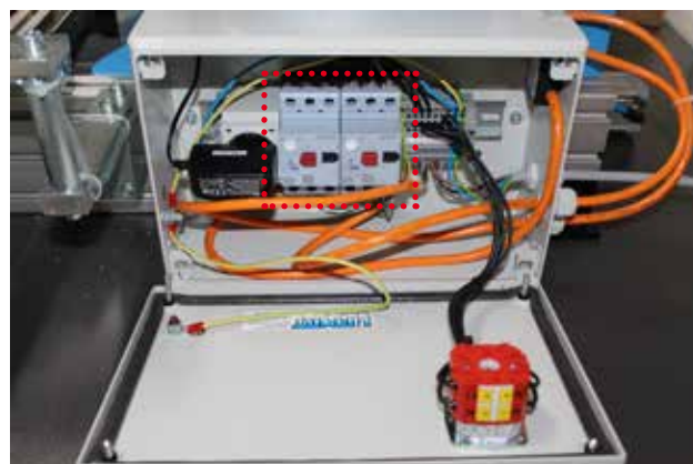
Rys.: Wyłącznik bezpieczeństwa silnika
