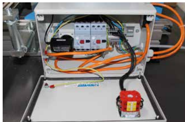
Фиг.: Превключвател за защита на двигателя
